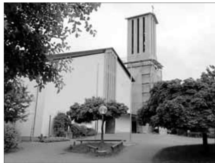
Das Gerüst steht noch, aber das Kreuz ist drauf: Die Kirche Don Bosco nach dem Austausch der Turmkrone. Foto: Scheider
